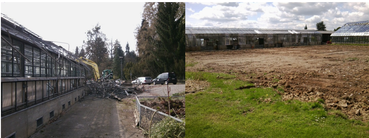
Abb. 6: Abriss von Gebäude 02.53. + 08.13
