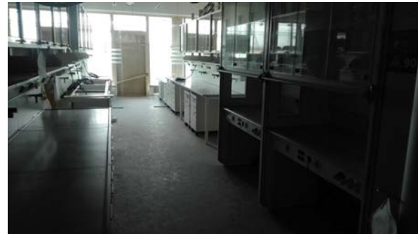
Abb. 16: Labor kurz vor Fertigstellung
