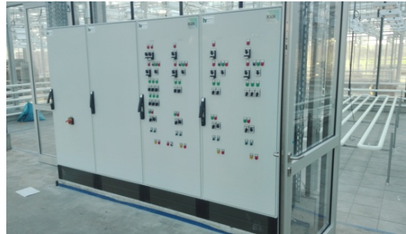
Abb. 12: Eingebaute Schaltschränke
