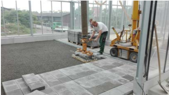
Abb. 11: Verlegung des Pflasters
