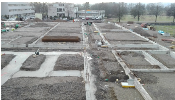
Abb. 7: Fundamente des Gewächshauses
