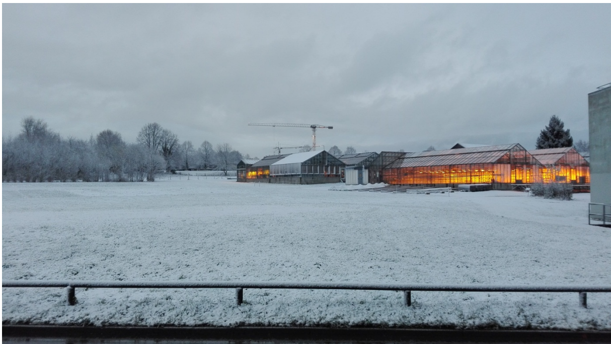
Abb. 1: Blick von der Fruwirthstraße nach Norden auf die Gewächshäuser 01.45 und 01.46.
