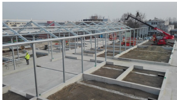
Abb. 8: Aufbau der Stahlträger
