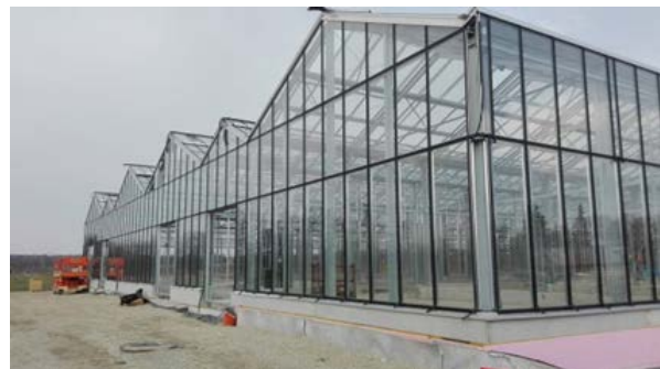
Abb. 10: Das Gewächshaus fertig eingeglast
