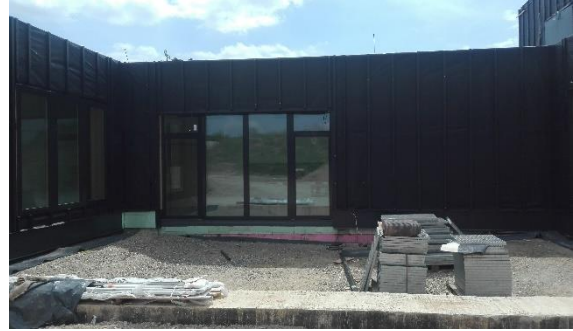
Abb. 3: Blick in den Innenhof
