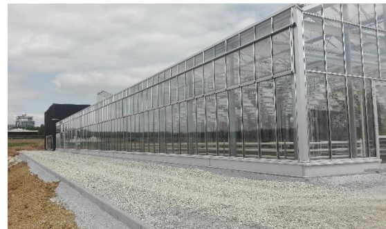
Abb. 5: Das Gewächshaus fertig eingeglast
