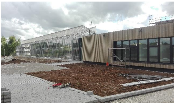
Abb. 6: Verlegung des Pflasters
