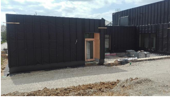
Abb. 2: Eingang zum Gebäude
