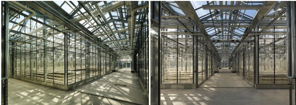
Abb. 7 + 8: Blick in den Gewächshausverbinder
