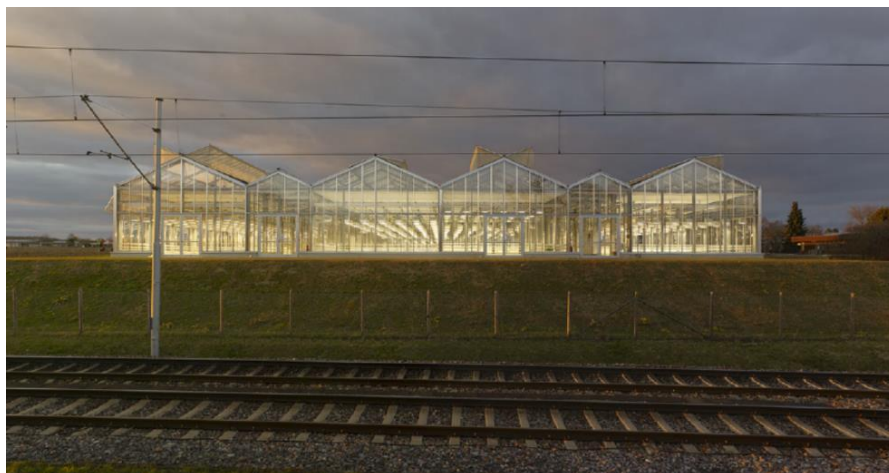
Abb. 11: Blick von Süden auf das Gewächshaus
