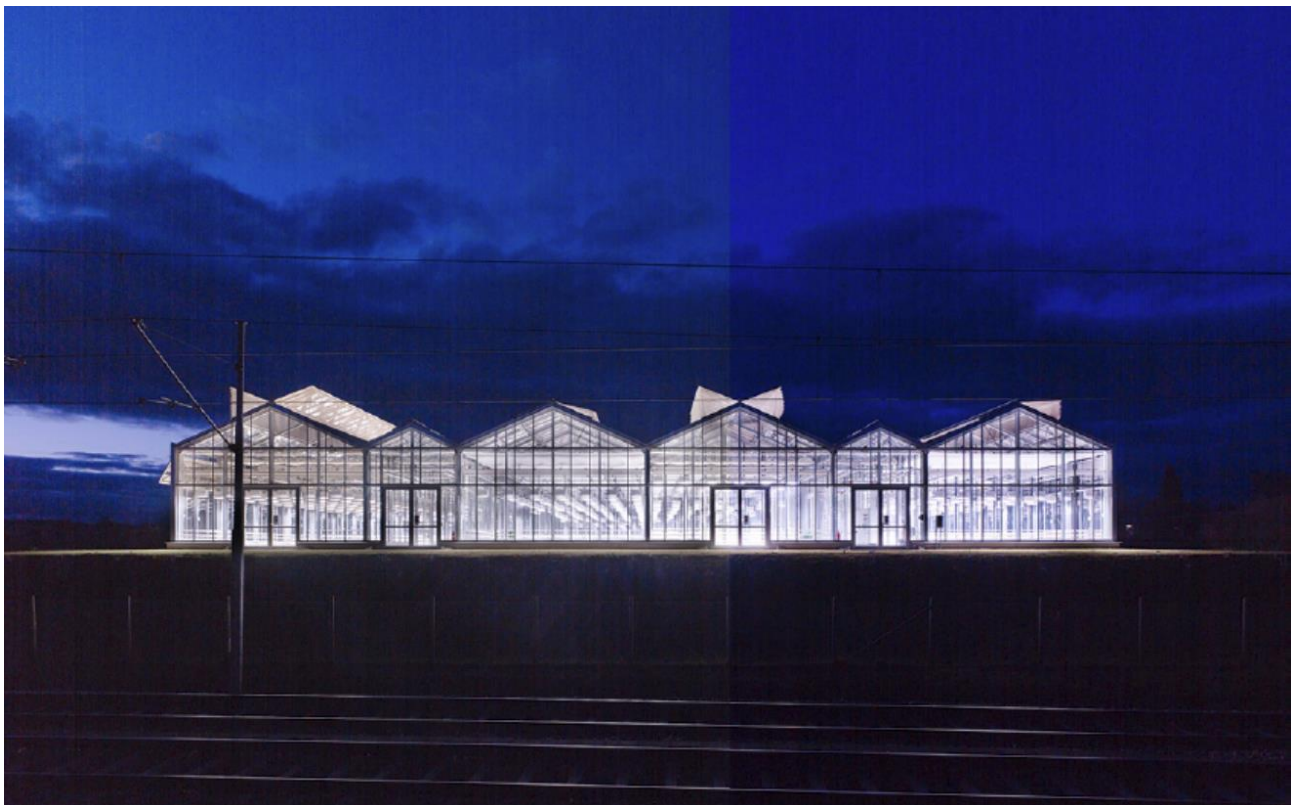
Abb. 16: Blick von Süden über die Gleise der Stadtbahn.
