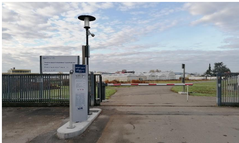
Abb. 12: Zufahrt nach Hohenheim West
